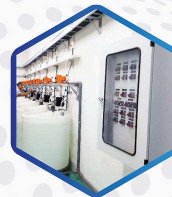
HỆ THỐNG CHÂM HÓA CHẤT
